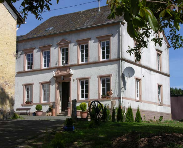
Historisches Gebäude erstrahlt in neuem Glanz und profitiert energetisch von modernstem Fenster-Komfort.
