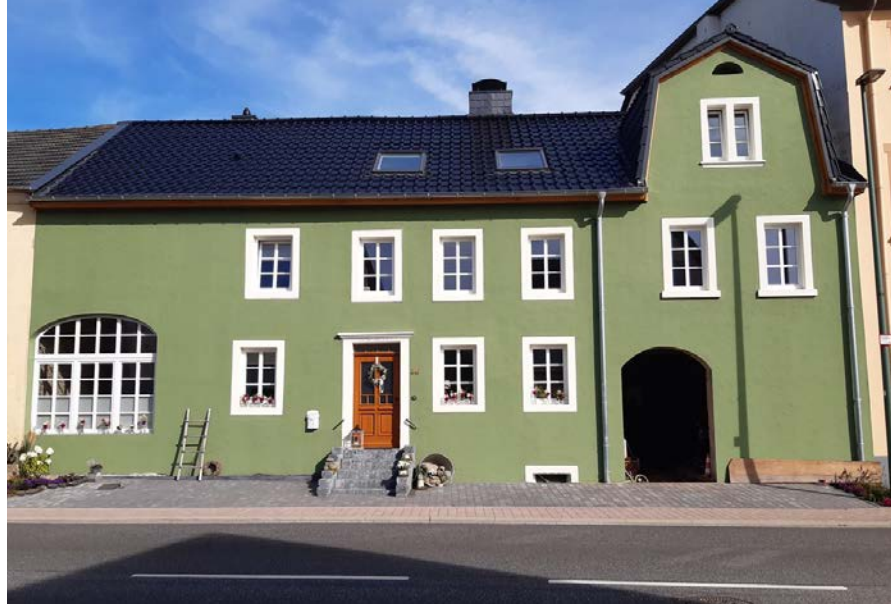
Moderne Sprossenfenster: Nach Kernsanierung ist dieses alte Bauernhaus in Pelm mit angrenzender Scheune ein echter Hingucker.
