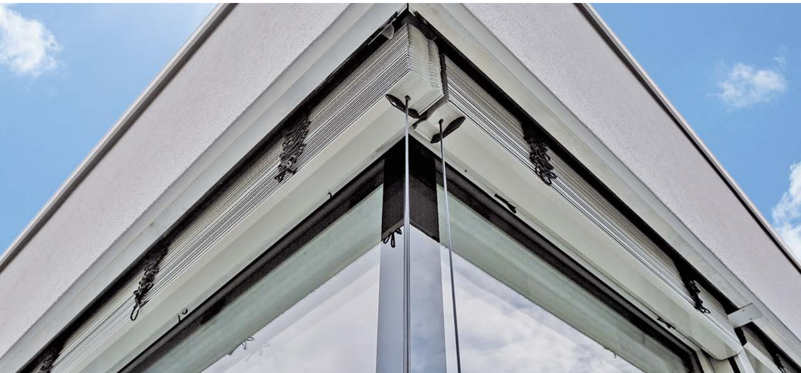
Eine Innovation Made in Kalenborn: Die Ganzglasecke kommt im Sichtbereich ohne störende Pfosten aus.
