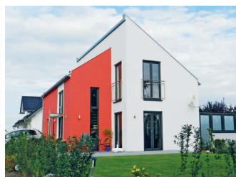
Sonderanfertigungen sind Standard: In der Nähe von Bitburg hat JOLEKA für diesen Neubau Fenster und Türen geliefert.
